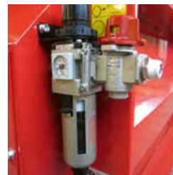
Afsluitklep voor perslucht (Alleen voor lucht modellen)
